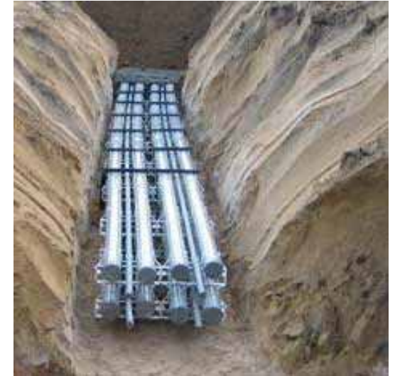
PVC Electrical Conduits
